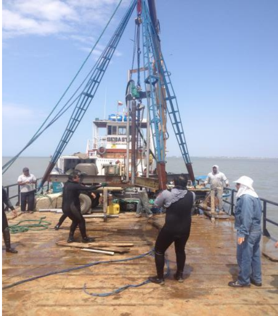
Fotografía N° 1: Sistema de perforación listo para lanzarse al agua.
