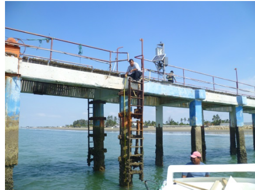
Personal en lectura de marea en el Muelle de Data Posorja
