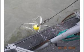
Fotografía N°35-36: Colocación del ADCP y el S4 en la estación 1
