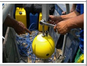
Fotografía N° 2: Instalación del S4 en la estructura de acero
