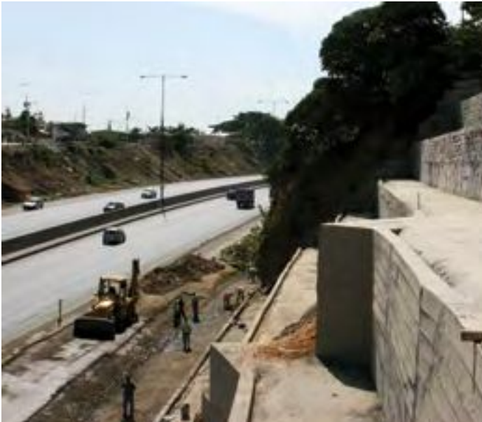
Foto 29. Obras de mitigación de riesgos. La planificación de actividades y coordinación entre las diferentes instituciones en el Cantón Guayaquil, ha permitido adecuar y concentrar los esfuerzos de prevención y respuesta ante potenciales emergencias. Fuente: Ilustre Municipalidad de Guayaquil.
