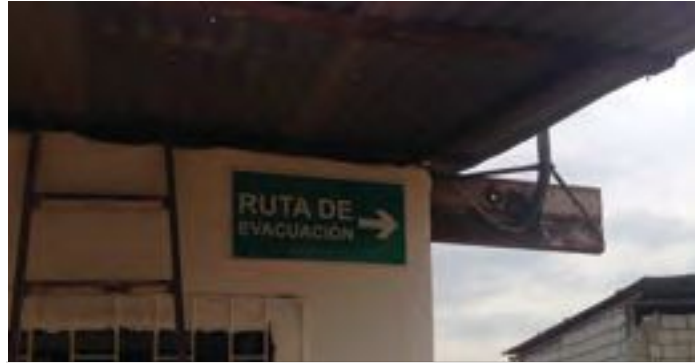
Foto 11. Instalación de señalética de rutas de evacuación. La aplicación palpable de los planes de emergencia se evidencia con la colocación de señalética apropiada para evacuación y los correspondientes simulacros para difundir y comprobar su correcto uso. Fuente: Ilustre Municipalidad de Guayaquil.
