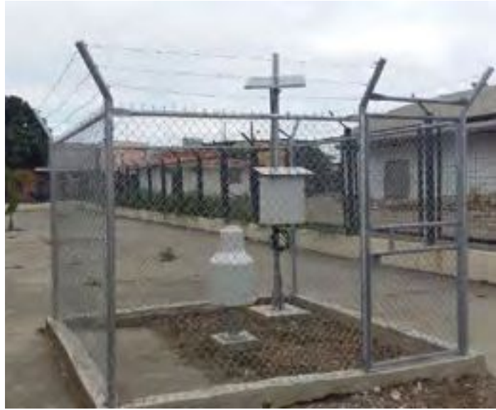
Foto 9. Instalación de las estaciones hidrometeorológicas. El establecimiento de un Sistema de Alerta Temprana parte de la información que se obtenga de los sistemas de monitorización de las amenazas; en el caso de Guayaquil, una de las amenazas de mayor recurrencia y efectos es la hidro climática. Fuente: Ilustre Municipalidad de Guayaquil.
