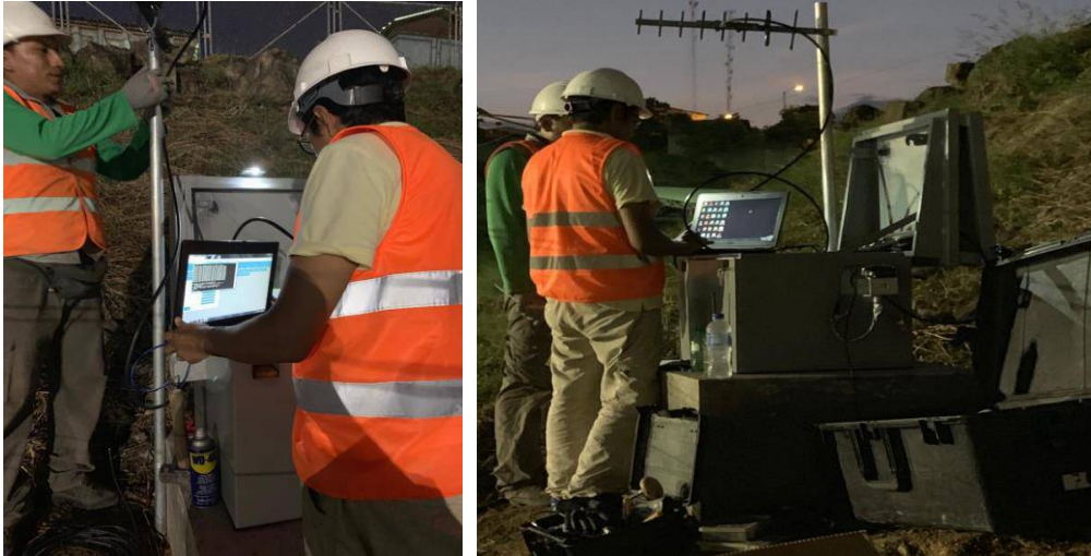
Fotos 45 y 46.- Instalación de acelerógrafos
