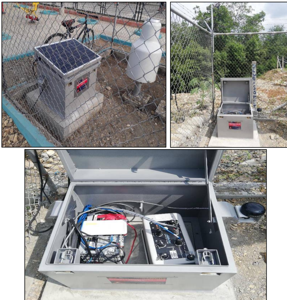
Fotos 47, 48 y 49.- Equipos Acelerógrafos instalados
