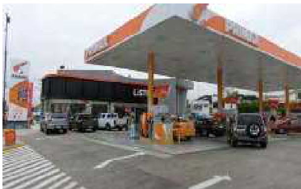
Fotografía 1: Acceso de la estación de servicio.
