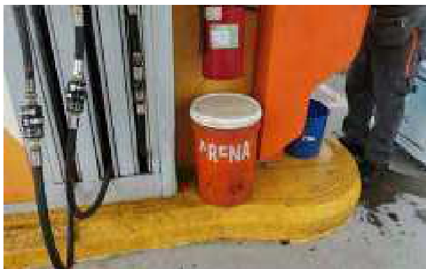
Fotografía 13: Material absorbente en el área de islas de despacho. Se observa extintor en la isla.
