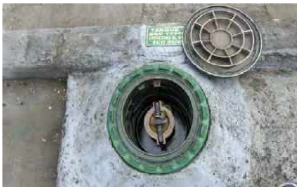
Fotografía 11: Tapa hermética en buen estado en el área de bocas de llenado.
