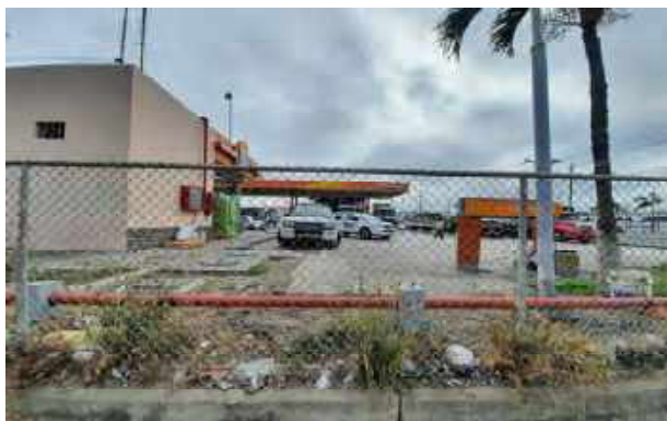
Fotografía 19: Se observa la red del sistema contra incendios.
