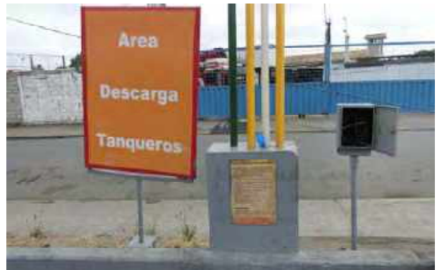
Fotografía 8: Se observa toma a tierra en el área de descarga.
