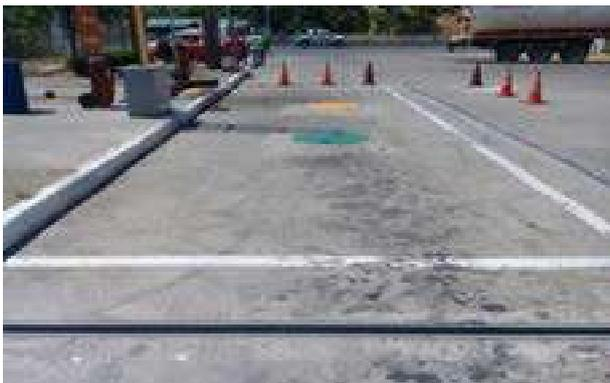
**Fotografía 11:** Canaletas de contención de derrames en el área de descarga.
