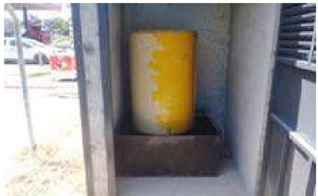
**Fotografía 16:** Cubeto de contención de combustible para el generador eléctrico.
