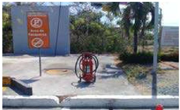
**Fotografía 18:** Extintor contra incendios en el área de descarga de combustibles.
