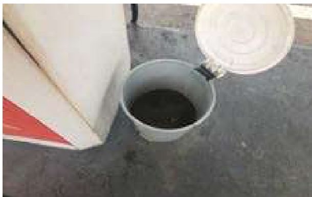
Fotografía 13: Material absorbente en el área de islas de despacho.
