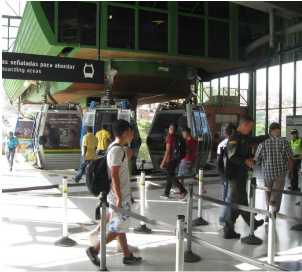
Figura 6. Estación de cable aéreo: Llegada/Salida de telecabinas
