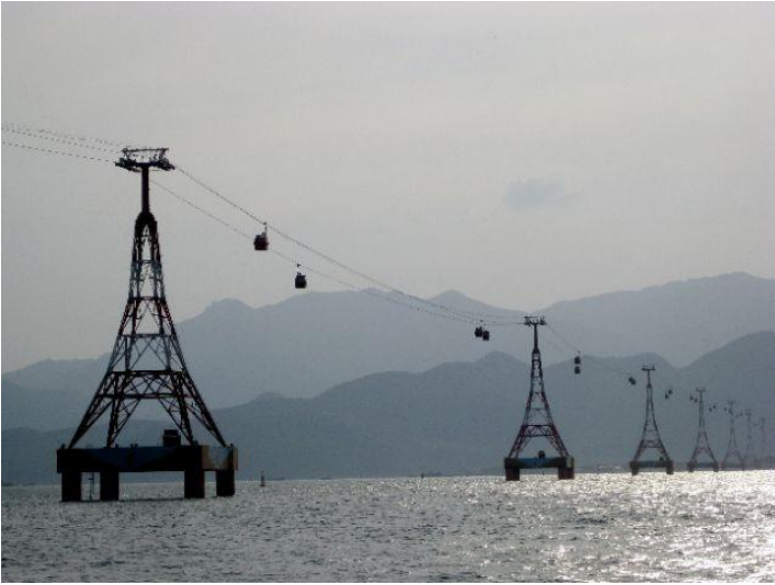
Figura 3. Base de piona sobre pilotes, en sistema de cable VinPearl de Vietnam. (Fuente: Internet)
